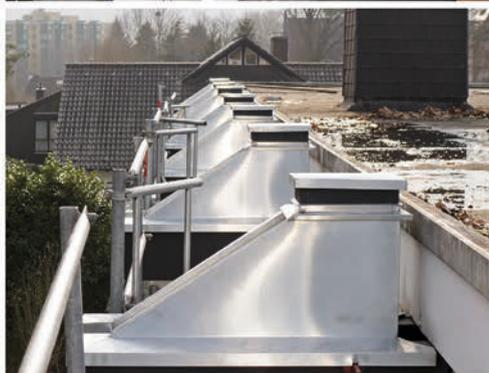
51. Austausch der Ständer und Binder, Nagelung gemäß Statik, Zinkabdeckungen als konstruktiver Witterungsschutz. Fotos: Hartmut Witte, 2014–2015.
