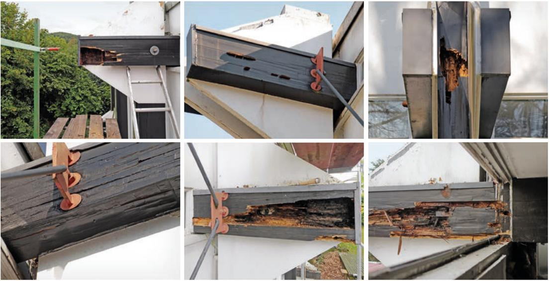
45. Fäulnissschäden, Schädlings- und Pilzbefall am Tragwerk. Fotos: Hartmut Witte, 2008–2012.
