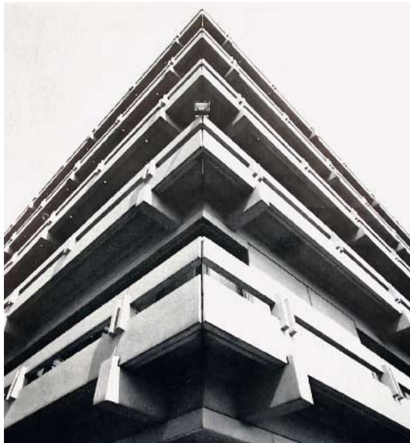
6 Dortmund, Pädagogische Hochschule, System Imbau (Architekten Lambart und Partner 1971–72). Eckansicht. 7 Dortmund, Pädagogische Hochschule, System Imbau (Architekten Lambart und Partner, 1971–72). Schnitt mit einer leicht variierten Brüstungslösung. 8 Hamburg, Verfügungsgebäude II der Universität Hamburg, System Imbau (Architekten Horst von Bassewitz und Carl Friedrich Fischer, 1972). Ansicht monolithische Brüstungen von innen, Foto Hillmann 2005.
