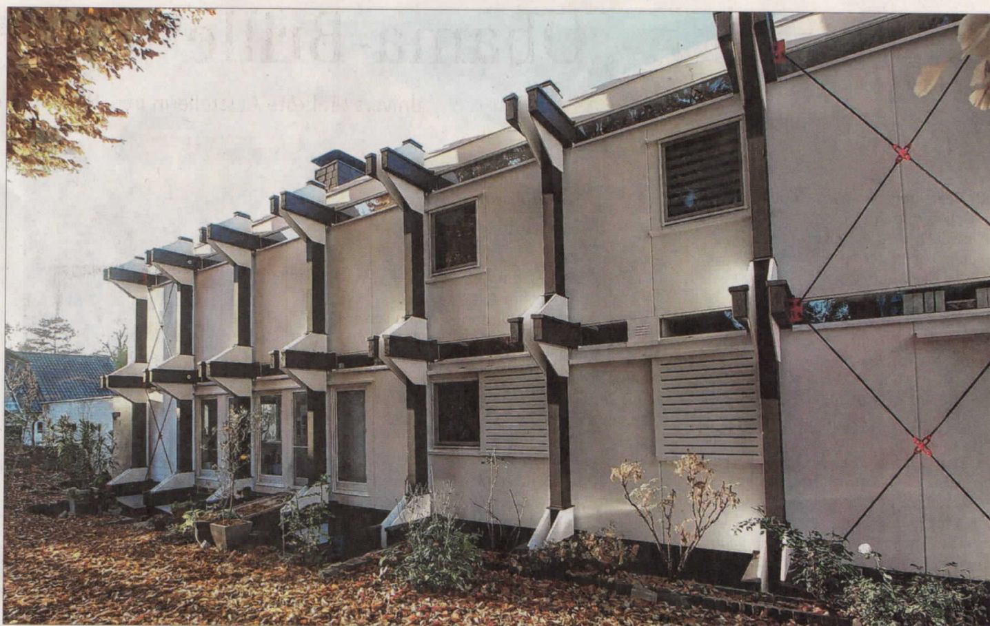
Die außergewöhnliche Optik ist auch nach der Sanierung erhalten geblieben. Das Haus in Bad Honnef sollte der Beginn einer neuen Ära im Einfamilienhausbau werden – mit modernen, preiswerten Materialien und einer kurzen Bauzeit.
